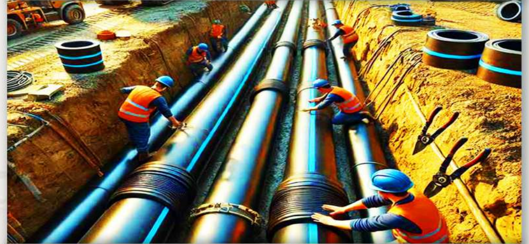
أعمال شبكة المياه
