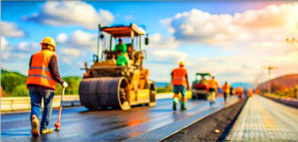
أعمال الطرق والأسفلت والتخطيط
