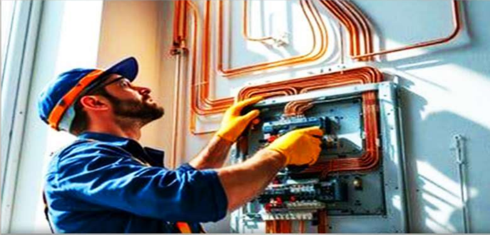
أعمال الكهرباء والإنارة
